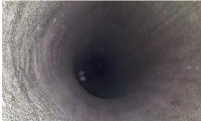
Sanierter runder Rauchfangquerschnitt
